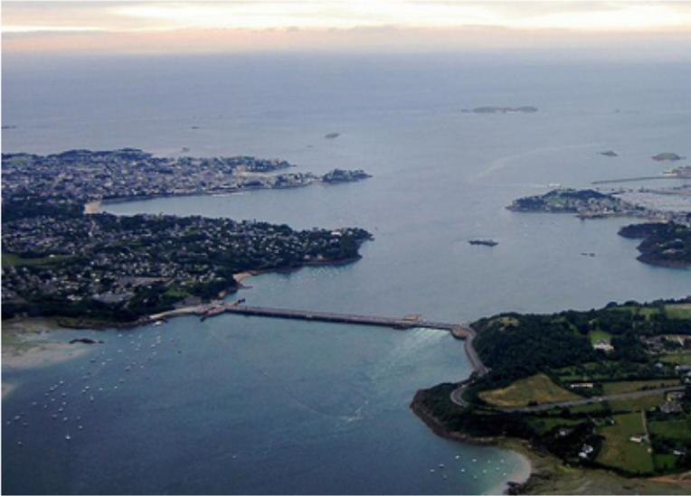
Während über den Staudamm die Autos rollen, drehen sich unter dem Staudamm die Turbinen des Gezeitenkraftwerks an der Rance. Die Rance ist ein Fluss, der bei Saint-Malo ins Meer fließt.
